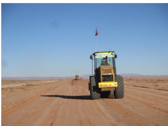
FIGURA 2: OBRAS EN LA RUTA N°21 UYUNI - TUPIZA
